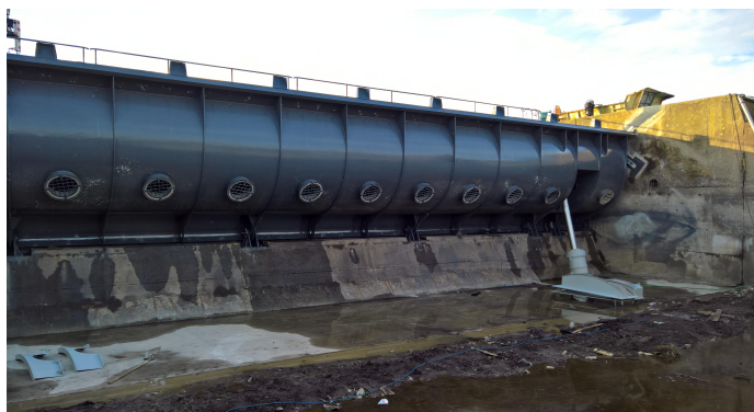
Foto č. 5 – Pohled na klapku při opravě – pravé jezové pole
